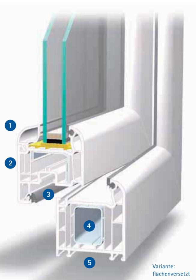
\*mit Verglasung  $U_g = 0,4 \text{ W}/(\text{m}^2\text{K})$  und  $\psi_g = 0,035 \text{ W}/(\text{mK})$
